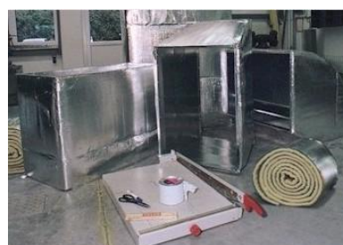
Isoleren van luchtkanalen
